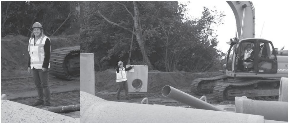
Albertine ging nog op de foto met de wethouder op de bouwplek
